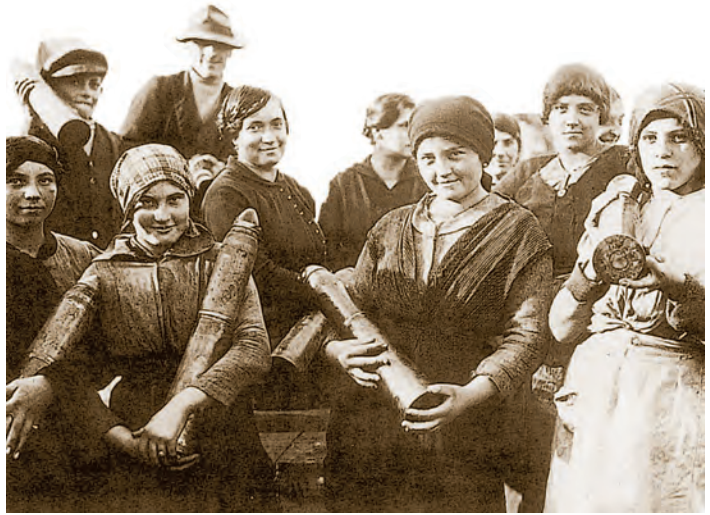
3. Εργάτριες σε εργοστάσιο πυρομαχικών κατά τον Α΄ Παγκόσμιο πόλεμο: όταν οι άντρες πήγαν στον πόλεμο, οι γυναίκες πήραν τις θέσεις τους στα εργοστάσια. Έτσι έγινε ένα ακόμη ουσιαστικό βήμα προς τη χειραφέτηση της γυναίκας.
